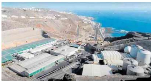
Vista de la planta de biometanización de Salto del Negro, a la derecha. cr
