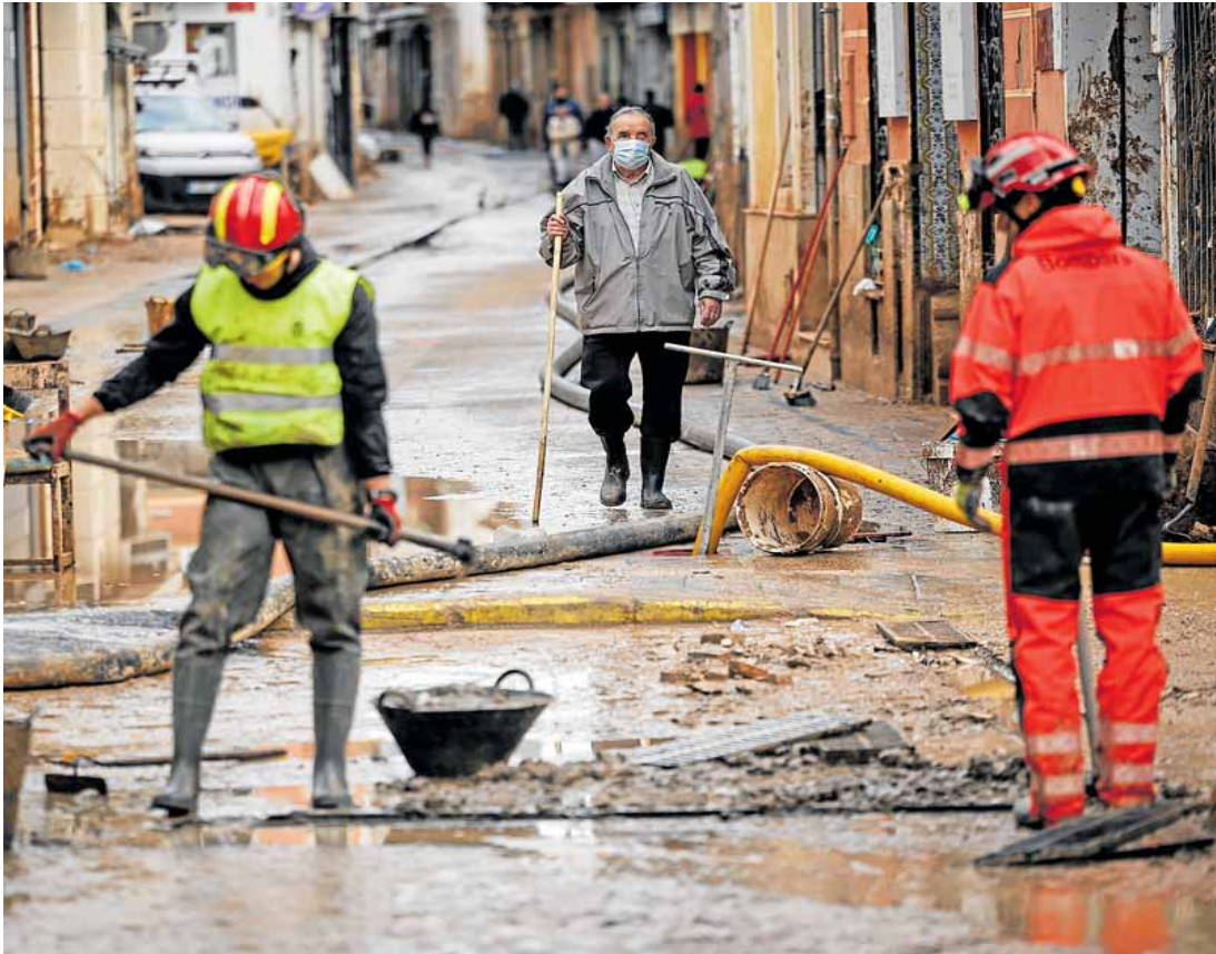
Efectivos de servicios de emergencia retiran barro del alcantarillado de Paiporta días después de la dana. EFE/BIEL ALÍÑO
