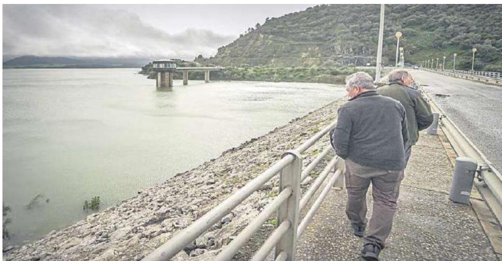
Dos personas comprueban el nivel del embalse del Guadalquivir en la provincia de Cádiz, el segundo mayor de toda Andalucía.
